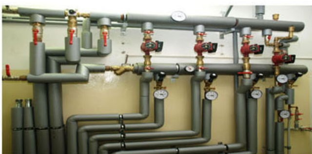
Rozdělovač ÚT, příprava tep. čerpadla, plyn / Kuthenka
